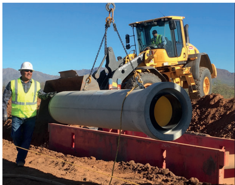
Укладка Perfect Pipe в округе Пима в штате Аризона в 2017 году
